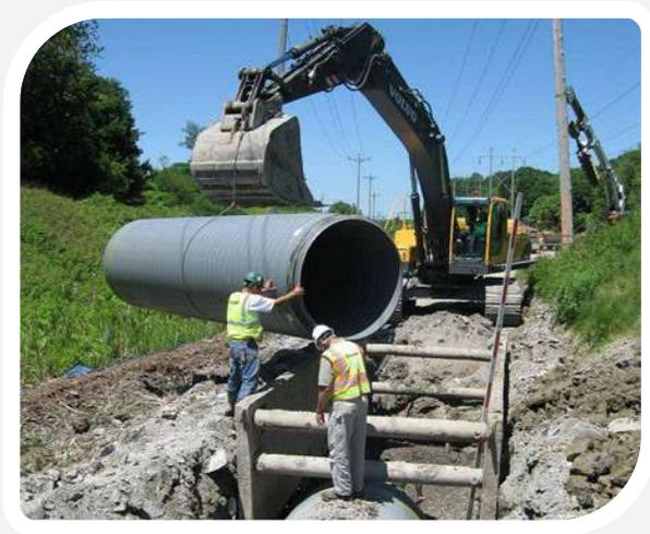
Tubería de GRAN DIÁMETRO, para desalojar de forma rápida el agua pluvial.
